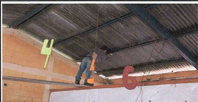
Foto 5: Cambio del sistema eléctrico del centro educativo
