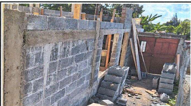
Foto1: Rehabilitación de la cocina del centro educativo
